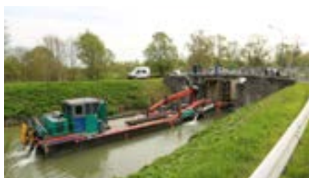
Pose des portes à l'écluse de Givry
