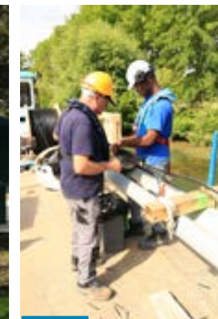
Pose de la fibre optique
