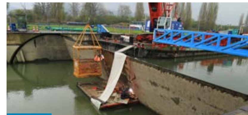
Réparation de la porte tournante de l'écluse de Notre-Dame-de-la-Garenne
