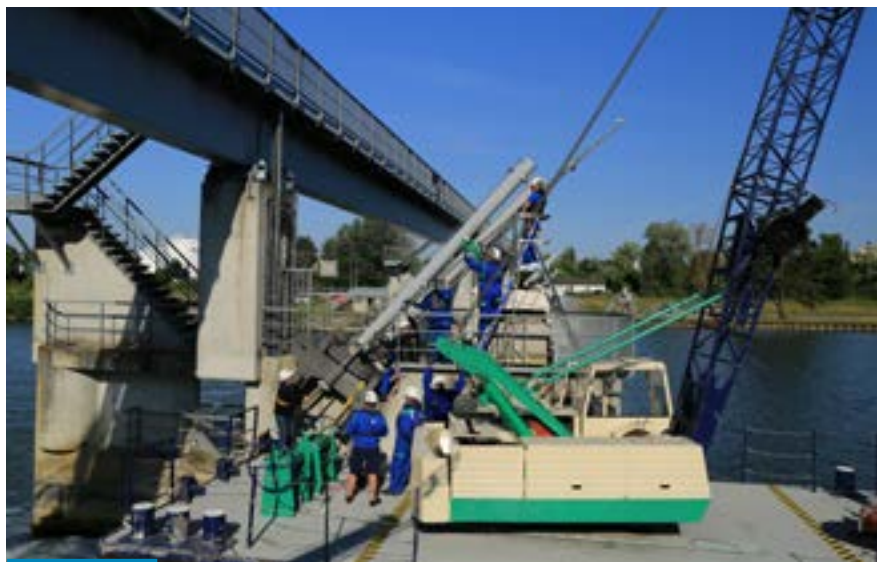
Dépose d'un vérin sur le barrage de Creil
