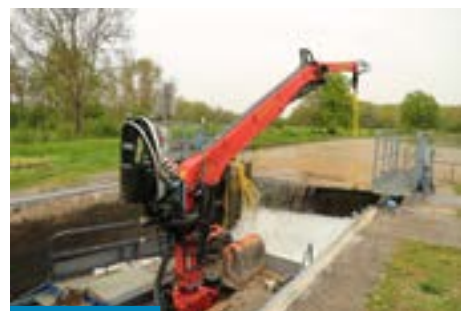
Vérification des vannes amont de l'écluse d'Asfeld
