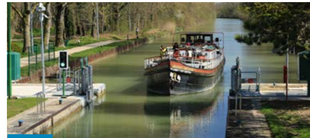
Téléconduite de l'écluse de Neuilly-sur-Marne
