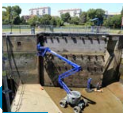
Rénovation des puits de vannes à Chatou
