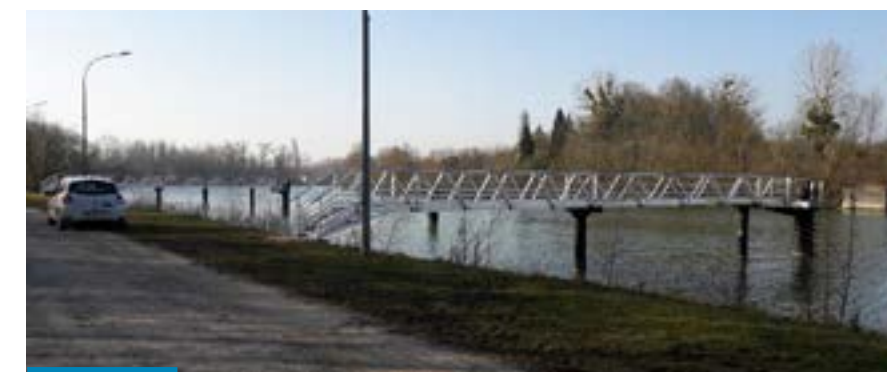
Remplacement des passerelles d'accès à l'écluse du Vezoult
