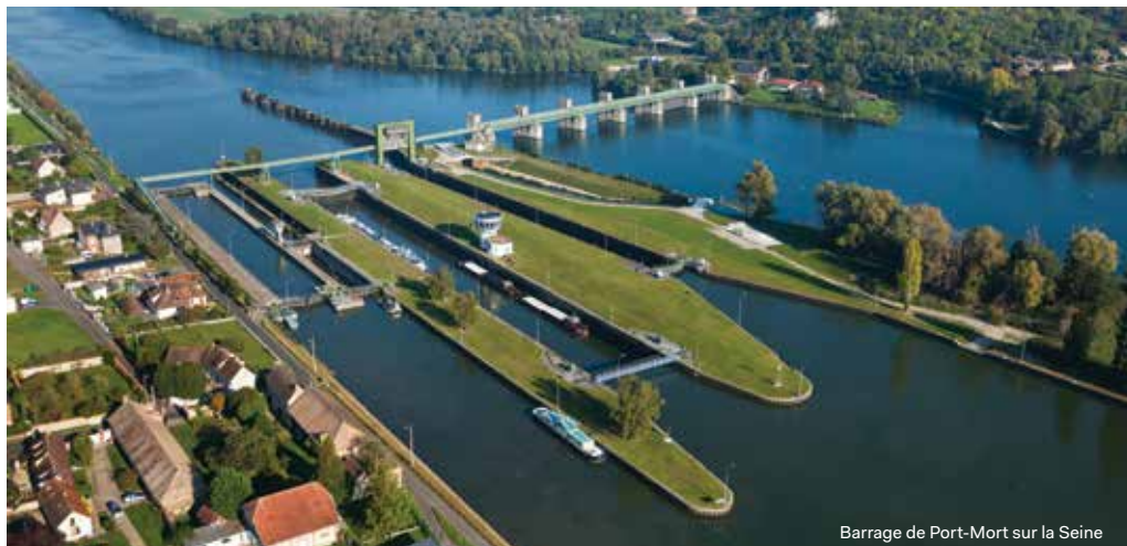
Barrage de Port-Mort sur la Seine
