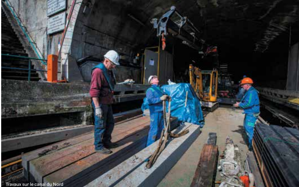
Travaux sur le canal du Nord
