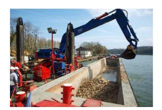
Les opérations de dragage précèdent celles de déroctage (concasser et retirer les roches dures) et portent sur toute la largeur de la rivière, préparant ainsi la zone de travaux des quatre prochaines années.
